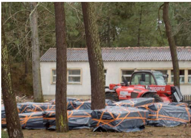
Désamiantage : conditionnement des déchets
