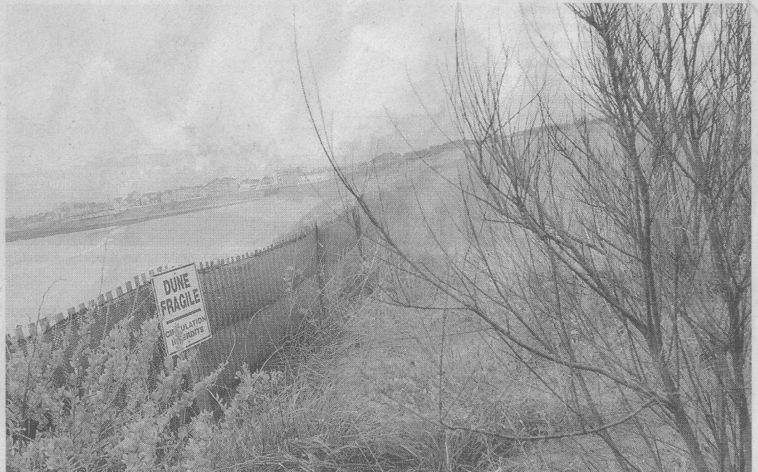
Des ganivelles, accompagnées de branchages, d'oyats, sont des solutions douces, destinées à protéger les dunes.
